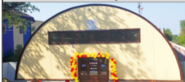
СКЛАДСКИЕ И ПРОИЗВОДСТВЕННЫЕ ПОМЕЩЕНИЯ
